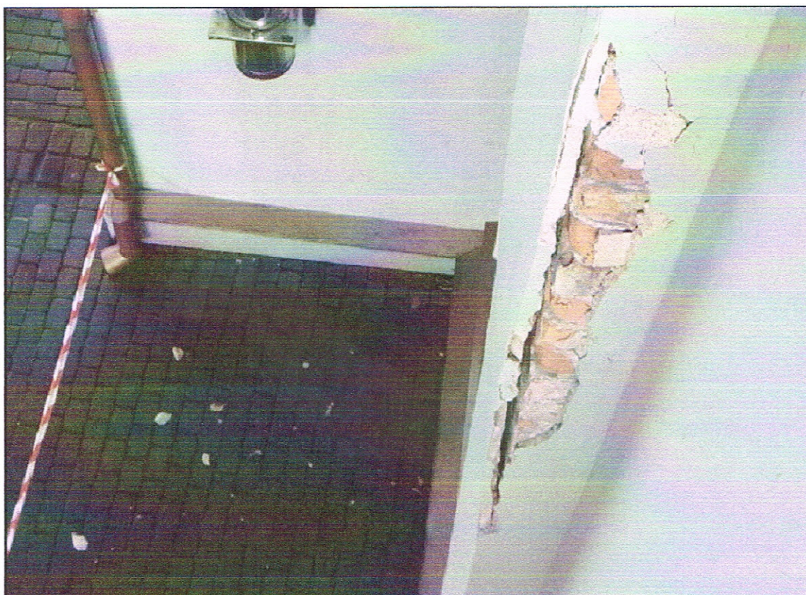
13.fotoattēls. Fasādes apmetuma erozija
